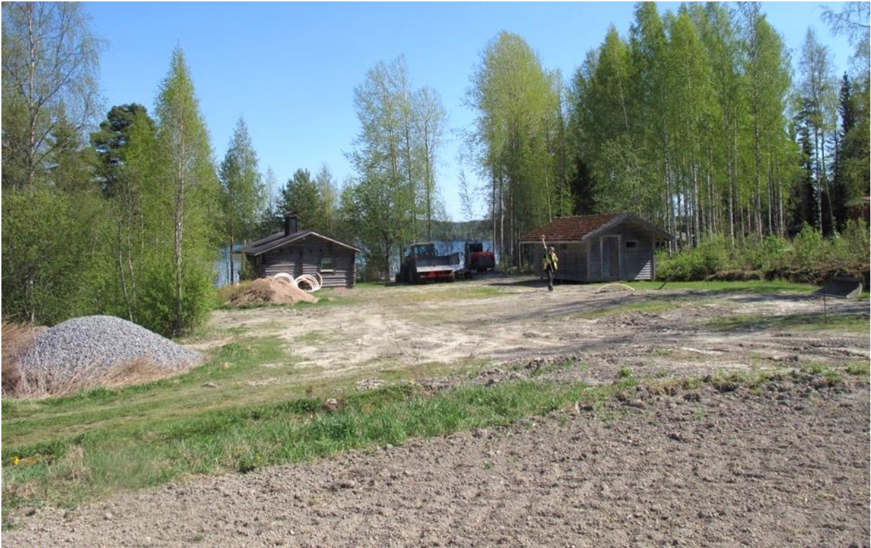
Kuva 19. Osalla tonteista tehtiin sähköverkon maakaapelointia ja vesihuoltoa varten kaivantoja. Maata oli muokattu voimakkaasti aivan selvitysalueen pohjoisrajan tuntumassa. Kuvattu lännestä. Kuva: Hannu Takala, Maanala Oy.
