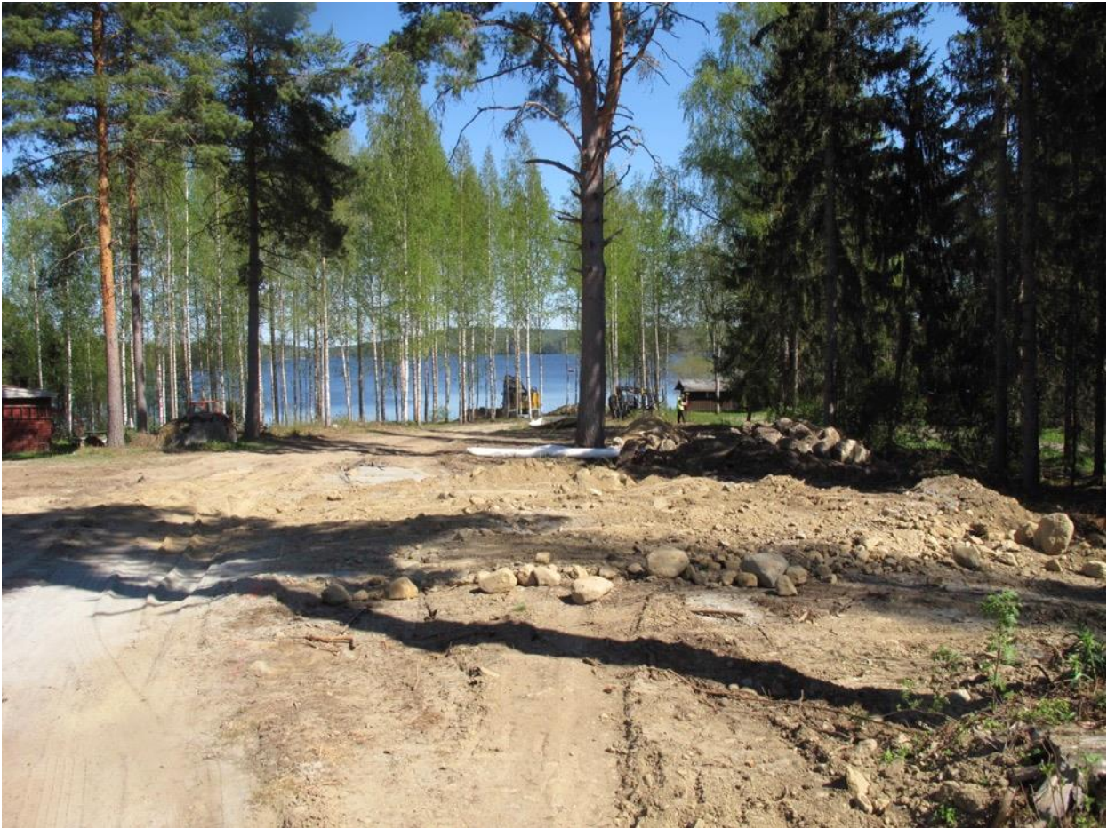
Kuva 15. Selvitysalueen pohjoisemmassa osassa olivat maansiirtotyöt käynnissä, minkä seurauksena laajat ja aiemmin koskemattomat maastokohdat eivät olleet enää alkuperäisessä tilassa. Kuvattu lännestä. Kuva: Hannu Takala, Maanala Oy.
