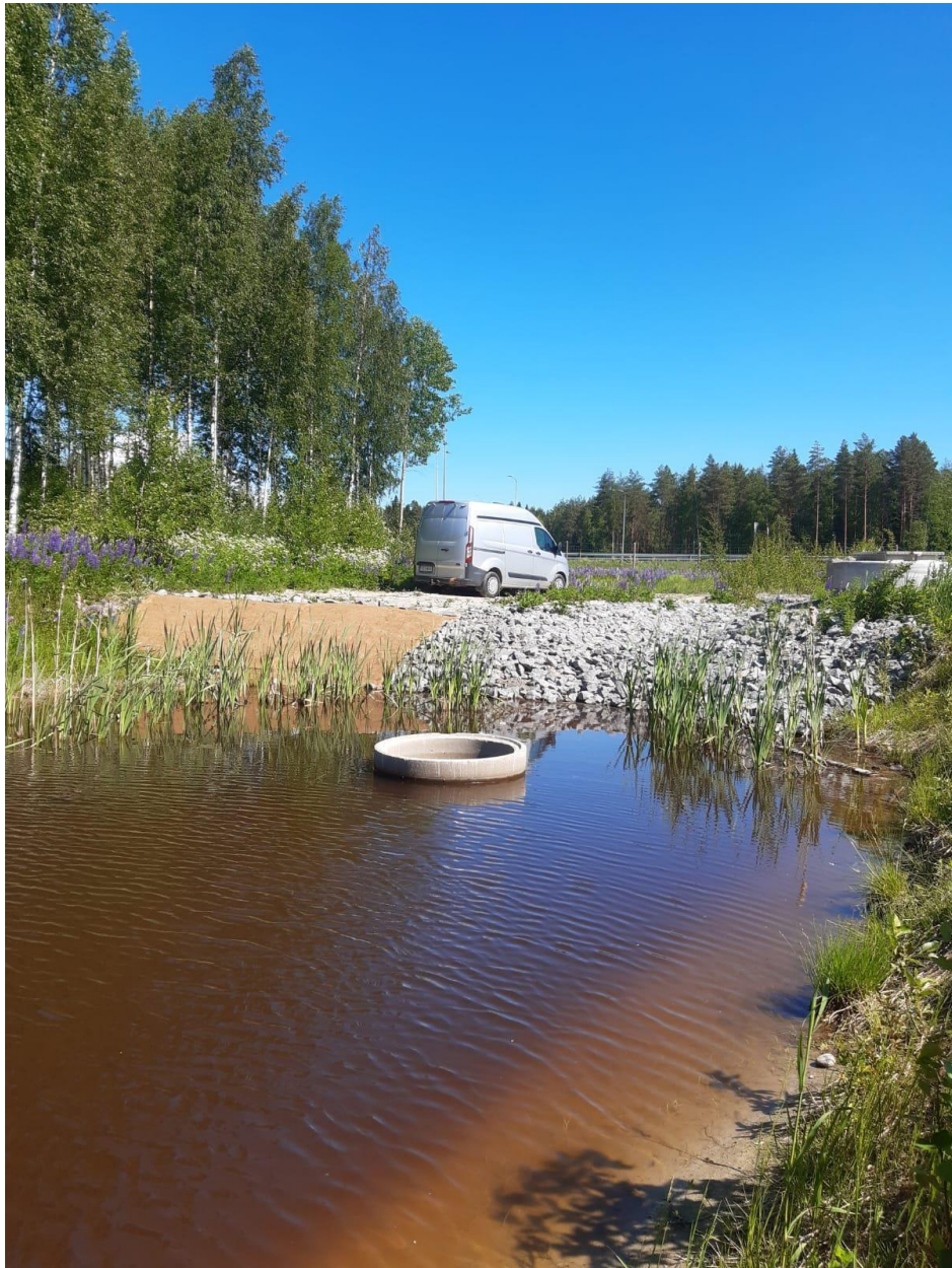
Huleveden viivästysallas kesällä 2024. Kuva: Markku Viitaniemi
