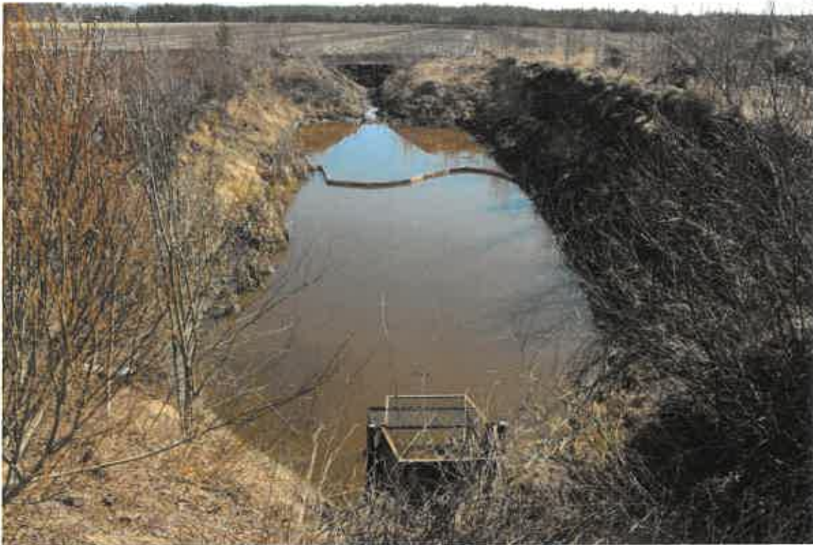
Kuva 13: Saostusvesiallas F2 Vihalaidansuon tealueen länsipuolella.
