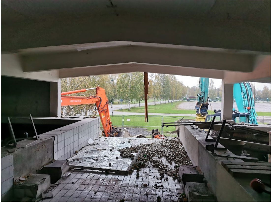
Kilpinokan vedenottamon purkutyömaa syksyllä 2023. Kuva: Raimo Luomala
