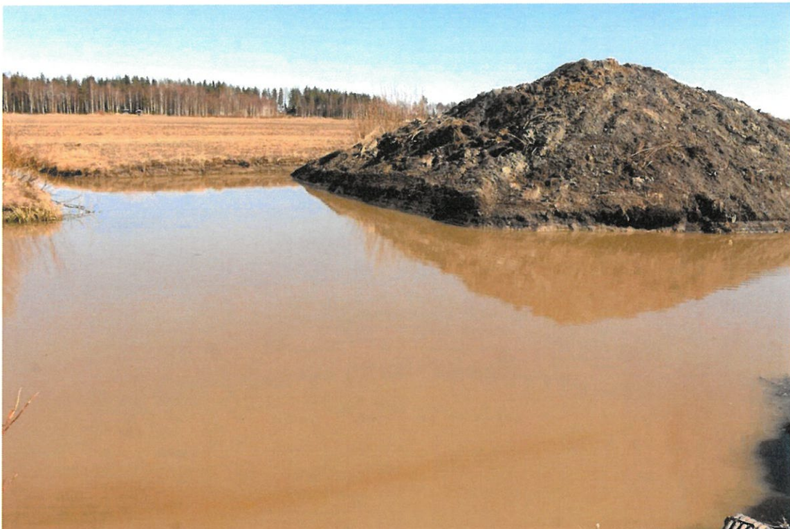
Kuva 14: Saostusvesiallas G Varvusensuon länsikulmalla.
