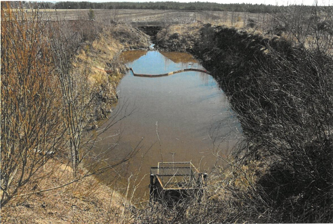
Kuva 13: Saostusvesiallas F2 Vihalaidsuon tiealueen länsipuolella.
