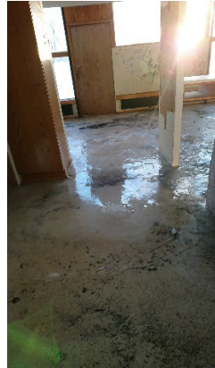
Asunto 2; vuotovedet jäätyneet rakenteisiin.
