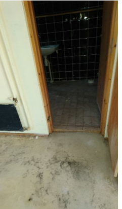
Asunto 2; vuotovedet jäätyneet rakenteisiin.
