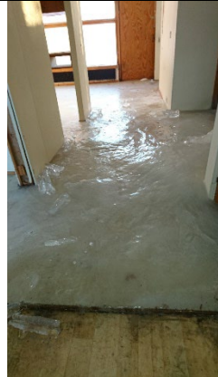
Asunto 1; vuotovedet jäätyneet rakenteisiin
