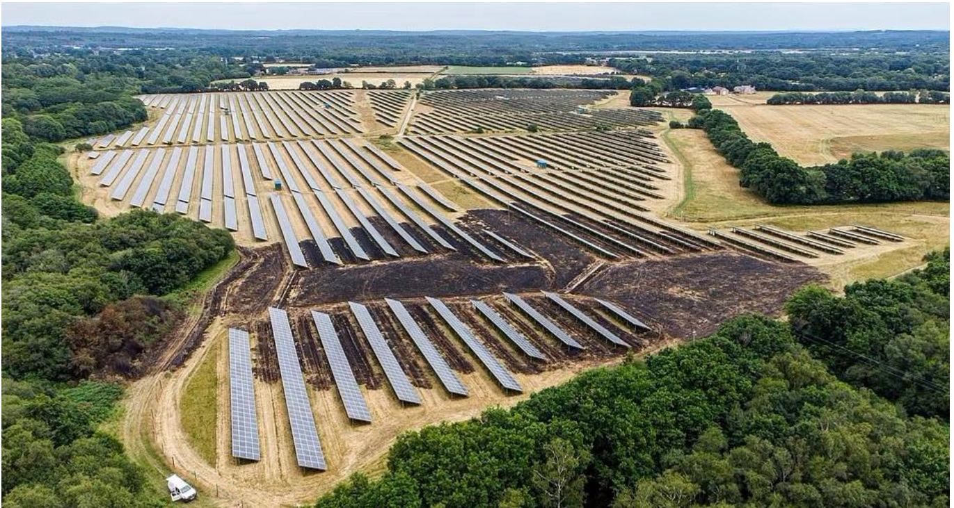
Yllä: aurinkosähkövoimalan ja ruohikon tulipalon jäljet Englannissa Verwoodissa 11.7.2022 tapahtuneen palon jälkeen. (Kuva: yllä Max Willcock/BNPS)
