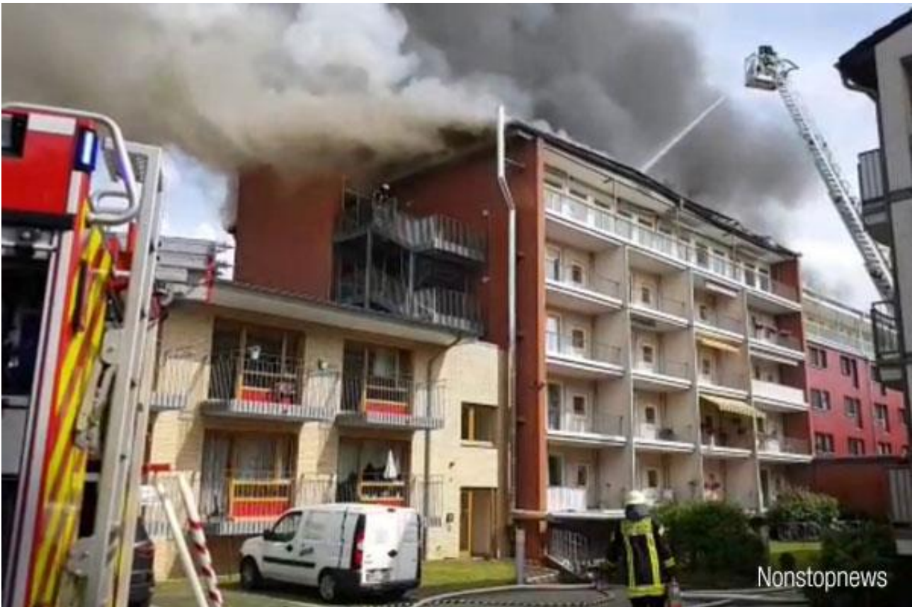
Aurinkosähköjärjestelmän tulipalo saksalaisessa hoitolaitoksessa/vanhainkodissa Bremenissä vuonna 2019. Tulipalossa evakuoitiin 96 hoitolaitoksen asukasta. Savulle altistumisen johdosta hoitoa tarvitsi 21 ihmistä, joista palomiehiä oli 2. (Feuerwehr-Magazin. 2019) (Kuva: Feuerwehr-Magazin / Nonstopnews)
