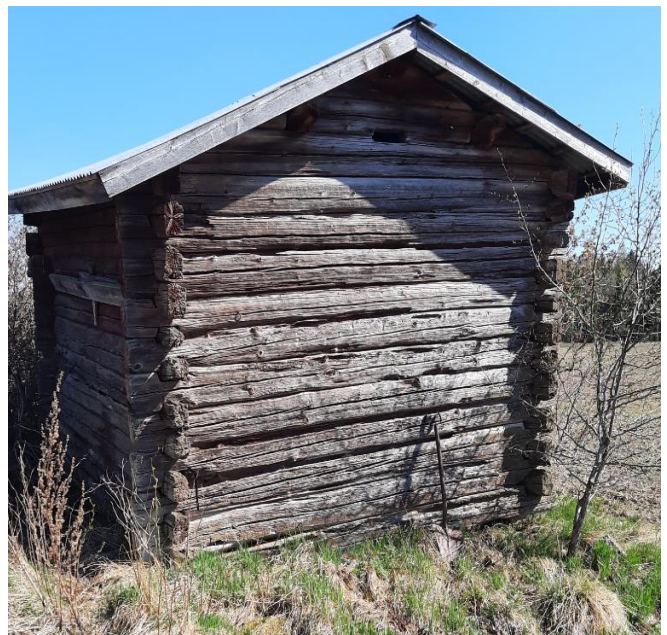
Kuva 45. Alimmaiset hirret ovat kiinni maaperässä.
