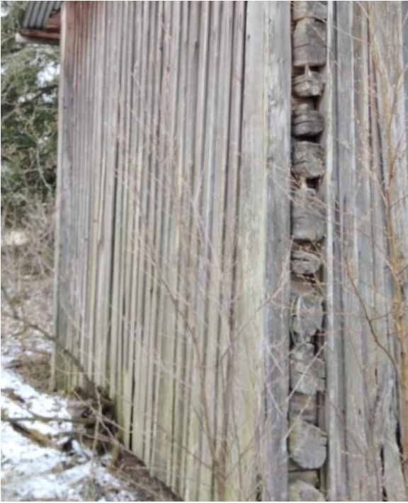
Kuva 55. Hirren päät ovat haperot.
