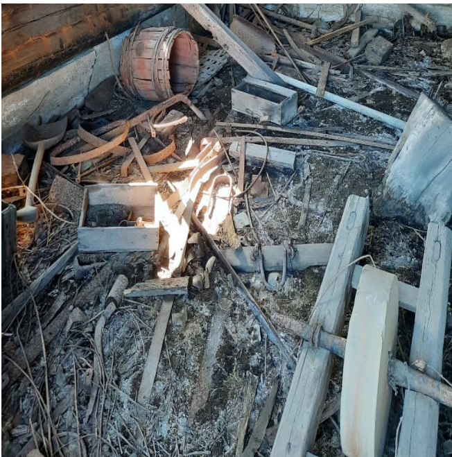
Kuva 36. Alapohja ja lattia.
