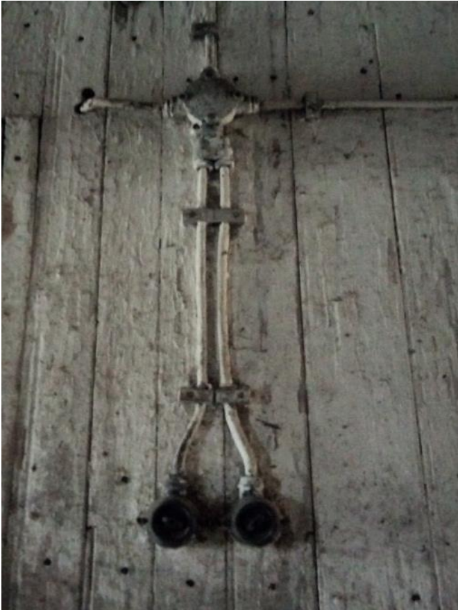
Kuva 29. Vanha jakokeskus ja kytkimet.
