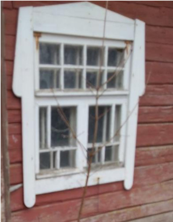
Kuva 103. Pääjulkisivun puolella ikkunoissa on kansallisromanttisia piirteitä.
