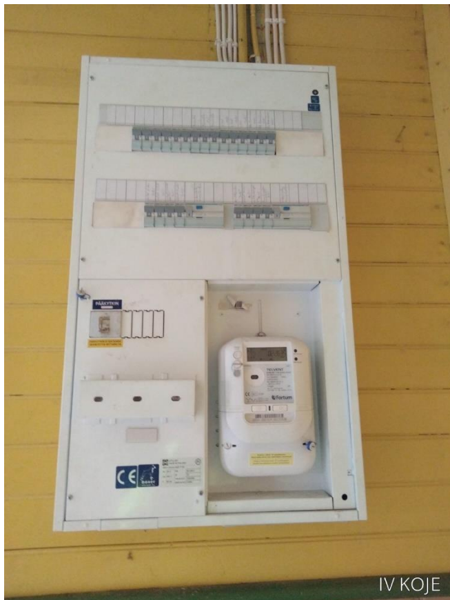
Kuva 138. Sähköpääkeskus.
