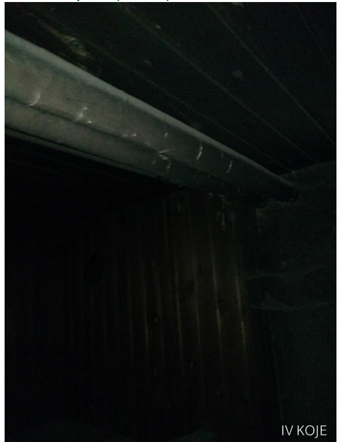
Kuva 41. Saunan läpi kulkevat lämpöputket, joiden eristeessä on asbestia.
