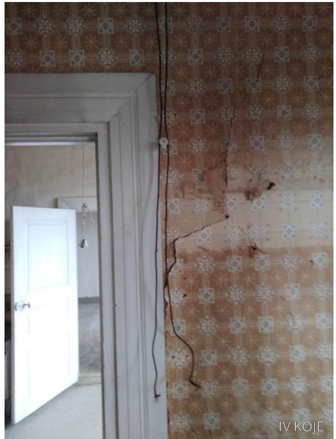
Kuva 90. Sähkökaapeleiden päät roikkuvat avonaisena.
