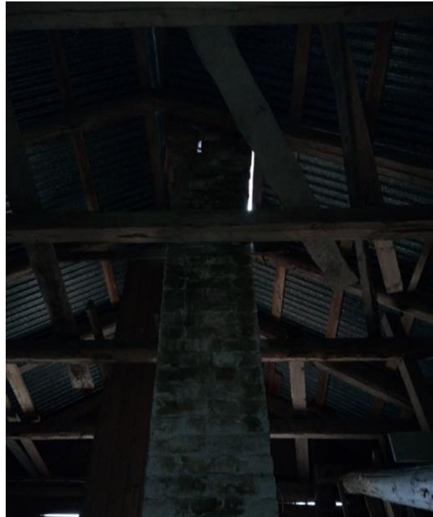
Kuva 20. Hormin ympärillä on aukko..
