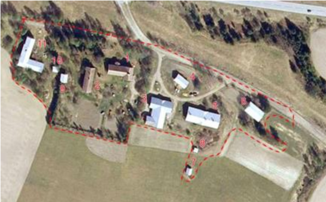
Kuva 1. Kohteeseen kuuluvat rakennukset, 1. päärakennus, 2. tyhjä asuinrakennus, 3. talli, sikala, suuli ja makasiini, 4. liiteri, 5. navetta, 6. suuli, 7. paja, 8-10 aitta, 11. kuivuri/suuli. (kuva: T. Silomaa 2018; Rakennetun ympäristön inventointi)
