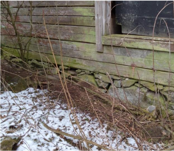
Kuva 47. Sokkelin kiviladontaa.
