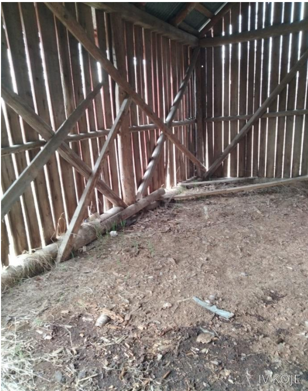
Kuva 116. Alajuoksu on kiinni maassa.
