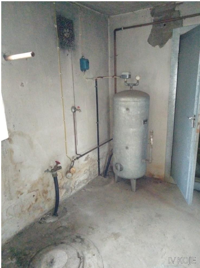
Kuva 10. Vesimittari irrotettu päävesilinjasta.
