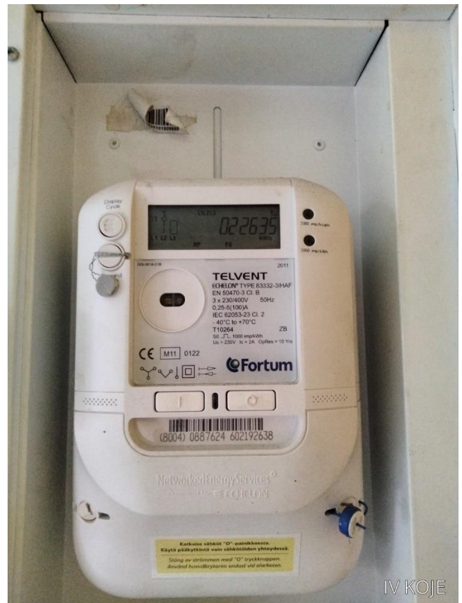
Kuva 149. Sähköpääkeskuksen etälukupäätelaite.
