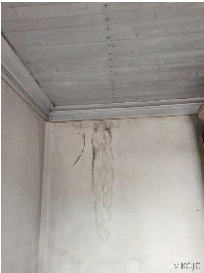
Kuva 81. Yleiskuva seinä- ja kattopinnasta.
