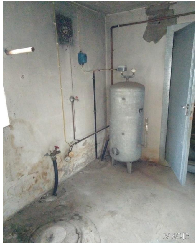
Kuva 16. Kellarin betoninen alapohja.
