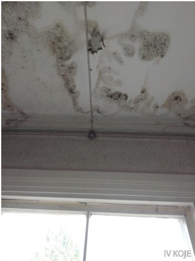
Kuva 83. Katon kasvillisuutta .
