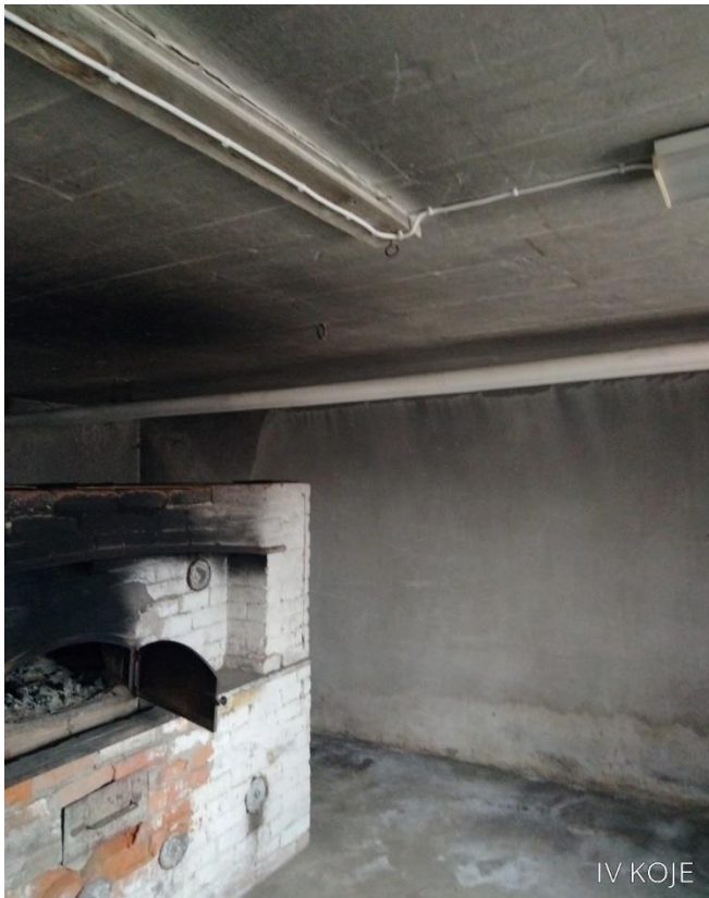
Kuva 15. Kellarin betoninen alapohja.
