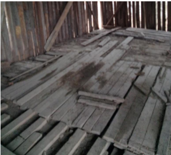
Kuva 31. Alapohja ja lattia.
