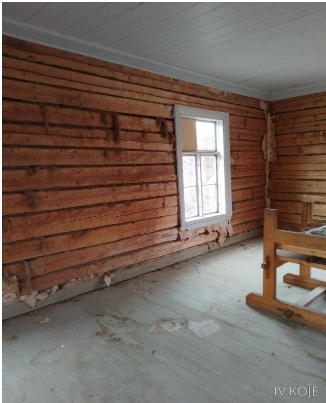
Kuva 79. Yleiskuva lattia ja seinäpinnasta.
