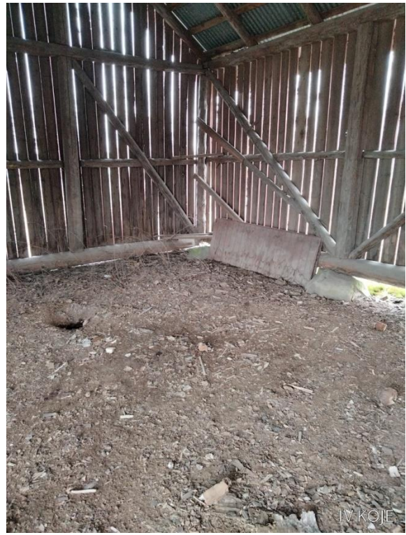
Kuva 117. Rakennus seisoo nurkkakivien päällä.
