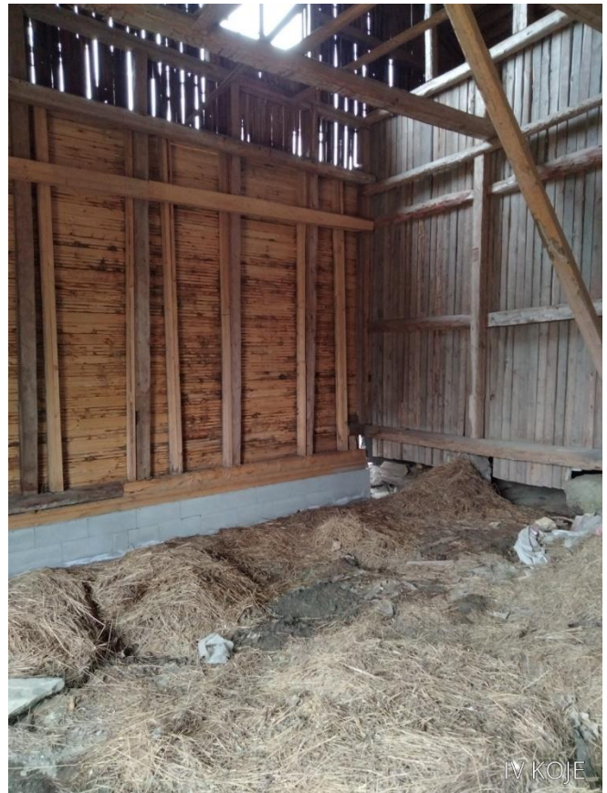
Kuva 95. Uusittua sokkeliä.
