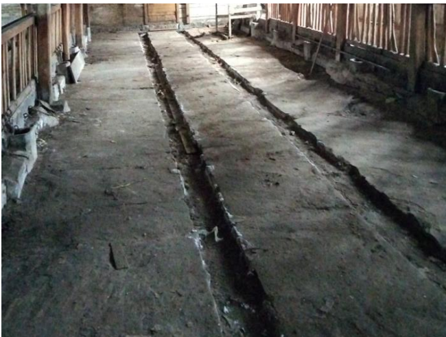
Kuva 119. Navetan lattia on raakabetonipinnalla.
