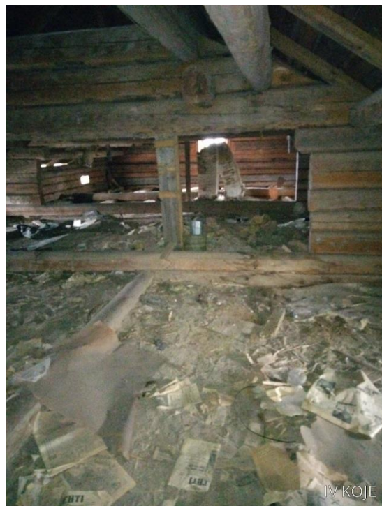
Kuva 9. Alkuperäisen osan hormoneja kallellaan.
