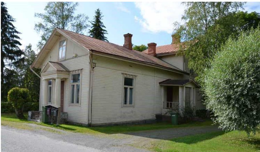
Vanha lakkitehdas, Rakennettu 1910/20, matala asuinosa rakennettu 1970 (kuva: Jari Heiskanen)
