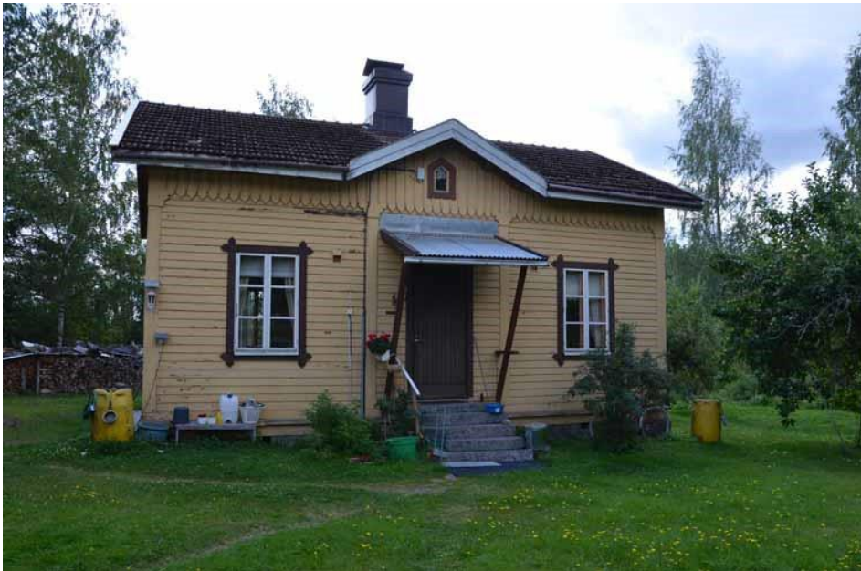
Kaksoisvahtituvan (tyyppi 2) piirustuksilla 1895 rakennettu asuinrakennus (kuva: Jari Heiskanen 2019)
