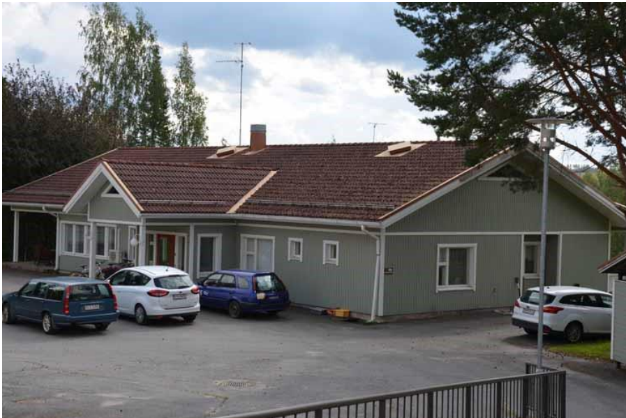
Karkkukodin asuinrakennus, rakennettu 1996 (kuva: Jari Heiskanen 2019)
